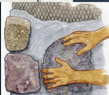
INSTALL THE FLATS
